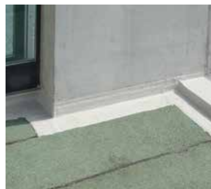
Dach płaski – Łączenie ze ścianą
