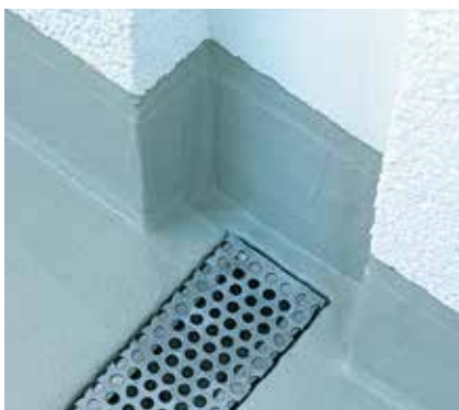
Balkon – Studzienka odpływowa i rynna
