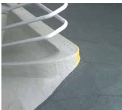
Parking wielokondygnacyjny – Krawężnik
