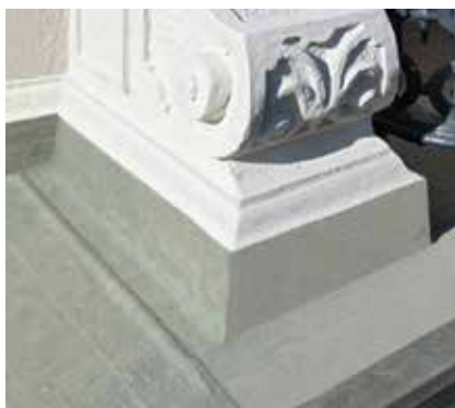
Balkon – Łączenie ze ścianą
