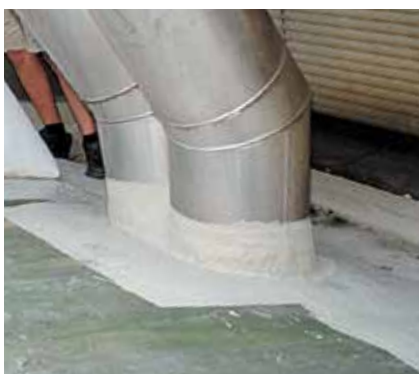
Dach płaski – Rura wentylacyjna
