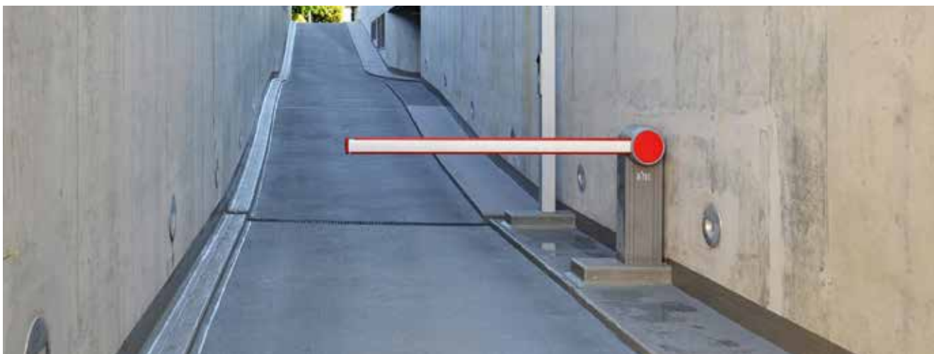
Rampa dojazdowa po renowacji za pomocą Triflex
