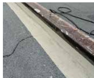
... zostały zabezpieczone za pomocą produktu Triflex ProDetail.
