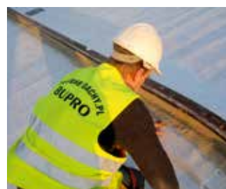
... i zapewnia dzięki temu długotrwałą szczelność dachu.
