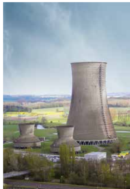
Elektrownia po renowacji za pomocą Triflex ProTect .
