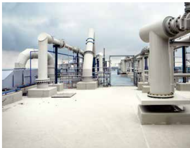
Dachy silosów są dobrze przygotowane do intensywnej eksploatacji nowej elektrowni RWE w Westfalii.
