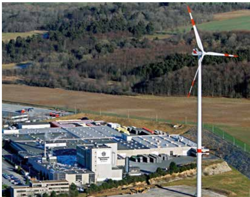
Browar w Paderborn po renowacji za pomocą Triflex Towersafe
