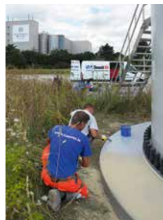
Nakładanie środka Triflex Towersafe Finish z posypką kwarcową
