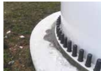
Nakładanie Włókny Triflex
