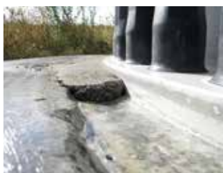
Użycie zaprawy murarskiej Triflex Cryl RS 240
