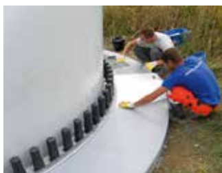
Nakładanie Włókny Triflex
