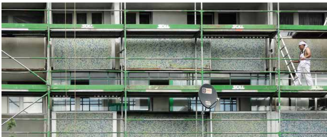
Firma B.D.P. Mirski+Dittrich Sp. z o.o. trwale uszczelnia 600 balkonów za pomocą systemu powłokowego Triflex BFS
