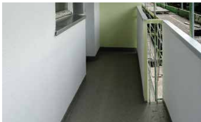
Powłoka wykonana za pomocą systemu Triflex BFS chroni balkony przed uszkodzeniami w wyniku wilgoci i poprawia ich estetykę.
