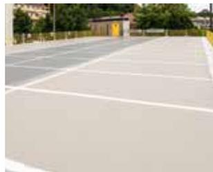
Das **Topdeck** Abdichtungssystem besteht durchgehend aus Polymethylmethacrylat (PMMA). Damit entsteht ein schub- und scherfester Verbund aller Lagen, der Delaminationen und somit Hinterläufigkeit verhindert.
