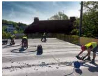
Massive Feuchteschäden an der Konstruktion, die aufgrund rissiger Fugen und Abplatzungen an der Oberfläche entstanden waren, machten eine Sanierung der Freidecks erforderlich.
