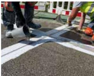
Mit **Triflex ProPark Var. II** haben die Verarbeiter der Kögel GmbH, Bad Oeynhhausen, eine neue vliesarmierte Nutzschicht geschaffen. Im Fokus standen zunächst die zahlreichen Fugen der Stahlbetonkonstruktion.
