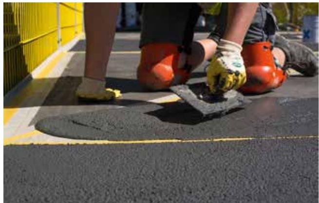
Die hochabriebfeste Nutzschicht wird flüssig appliziert und mit der Kelle verarbeitet. Sie sorgt dafür, dass die Oberfläche den extremen mechanischen Belastungen durch die Fahrzeuge dauerhaft standhält.
