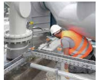
Die Detailabdichtung bindet auch die zahlreichen Befestigungspunkte nahtlos in die Abdichtungsfläche ein.
