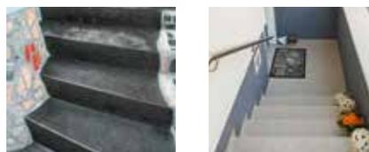
**Triflex TSS** è un rivestimento spesso concepito appositamente per le scale. La malta autolivellante resiste in maniera duratura alle forti sollecitazioni meccaniche alle quali sono sottoposte le scale. Triflex vanta oltre 45 anni di esperienza nel risanamento degli edifici con sistemi d'impermeabilizzazione e di rivestimento duraturi.
