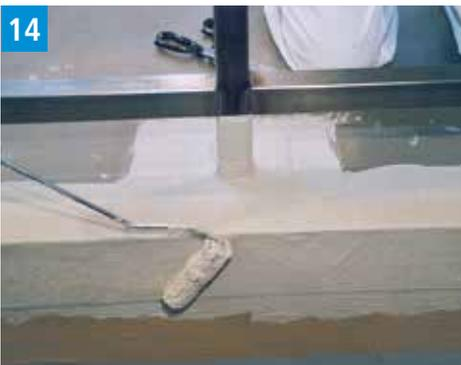
Infine rimuovere il nastro adesivo sul bordo anteriore quando il materiale è ancora fresco.
