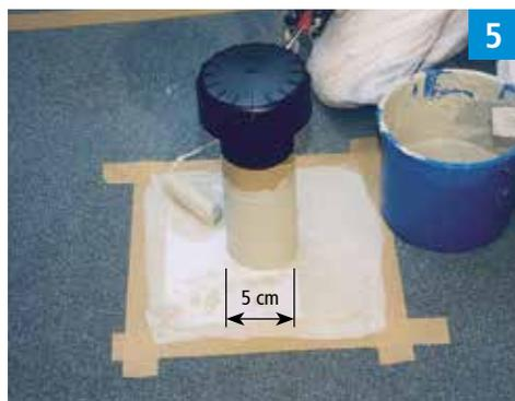
Stendere la resina d'impermeabilizzazione sulla superficie, applicare il secondo ritaglio per la superficie evitando la formazione di bolle d'aria e ricoprire abbondantemente partendo dall'alto.
