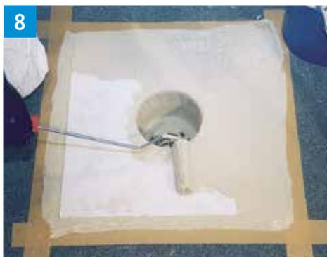
Togliere il panno dal pozzetto e rimuovere il nastro adesivo quando il materiale è ancora fresco.
