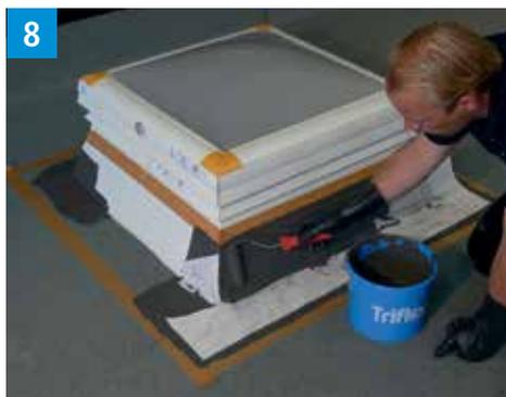
Stendere un abbondante strato di resina d'impermeabilizzazione sulla porzione di superficie contigua.
