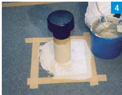
Stendere la resina d'impermeabilizzazione sulla superficie, applicare il primo ritaglio per la superficie evitando la formazione di bolle d'aria e ricoprire abbondantemente partendo dall'alto.
