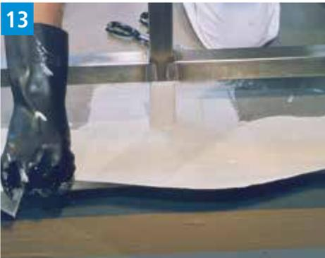
Premere con il rullo evitando la formazione di bolle d'aria e ricoprire ancora una volta con un abbondante strato di resina d'impermeabilizzazione.
