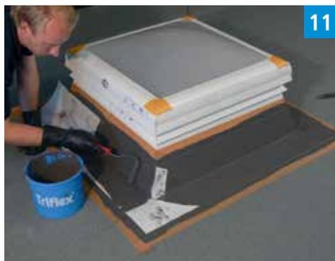
Quindi ricoprire ancora una volta il tessuto con un abbondante strato di resina d'impermeabilizzazione.
