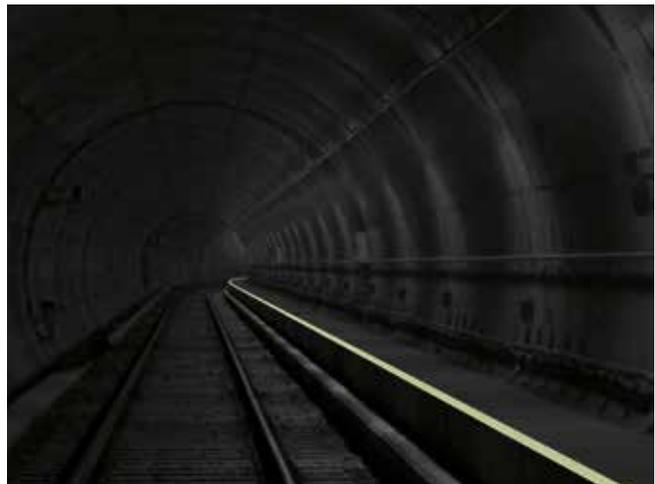
**Preco Line 300 NightLine** è una vernice monocomponente a strato sottile per segnaletica con proprietà luminescenti, utilizzata su manti in asfalto e calcestruzzo. È collaudata in base alla norma DIN 67510 Parte 1, Classe A (v. rapporto dell'istituto federale tedesco per la ricerca e la verifica dei materiali BAM: VIII.1E2046, piastra campione n° 1). Con uno spessore dello strato pari a 0,6 mm, l'ente tedesco BAM ha misurato il seguente tempo di estinzione:
