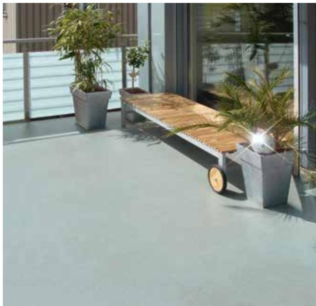
**Triflex BTS-P** è un'impermeabilizzazione di alta qualità armata con tessuto non tessuto speciale Triflex su tutta la superficie, impiegato su spazi utilizzati o aree ad alto rischio di fessurazione e in grado di tollerare elevate sollecitazioni meccaniche. Il sistema in resina di polimetilmetacrilato (PMMA) sviluppato appositamente per balconi, terrazze su tetto e portici protegge l'edificio in modo sicuro a lungo termine.
