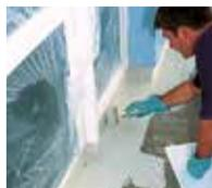
3. In primo luogo vengono impermeabilizzati i dettagli con Triflex ProDetail.
