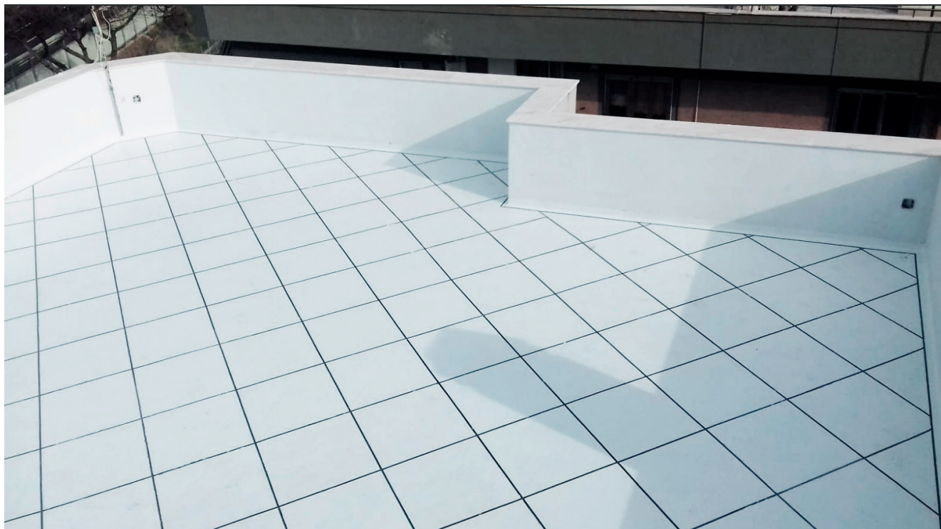
Terrazza dopo l'intervento di riqualficazione
