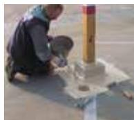
3. In primo luogo vengono impermeabilizzati tutti i dettagli con Triflex ProDetail e...
