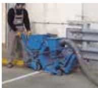
1. Pretrattamento del sottofondo, ad es. con pallinatura.
