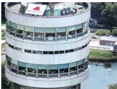
Donauturm, Wien (AT) • Besonderheit: Kupferdach • Objektgröße: 220 m 2 • Rippenmarkierung • System: Triflex ProDetail • Fertigstellung: 2013
