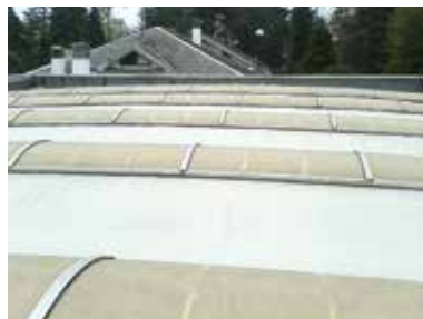
Werkshalle, Besnate (IT) • Besonderheit: Bogenförmiges Dach • Objektgröße: 900 m 2 • System: Triflex ProTect • Fertigstellung: 2014
