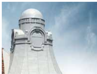
Türme Apartmenthaus, Wien (AT) • Besonderheit: Denkmalgeschützte Blechdächer • Objektgröße: 2 x 180 m 2 • Systeme: Triflex ProDetail, Triflex ProFibre, Triflex MetalCoat • Fertigstellung: 2015
