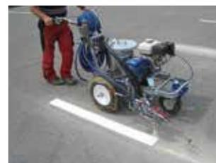
**Triflex ParkLine** s'utilise en extérieur comme produit de marquage pour les surfaces de parking et les places de stationnement. La peinture bicomposant haute résistance contenant peu de solvant à base de résine époxy peut s'utiliser sur les revêtements en asphalte et en béton. La couleur Triflex ParkLine pulvérisable offre une très bonne adhérence sur les supports présentant une humidité résiduelle. Grâce au séchage rapide, les temps de fermeture de la zone traitée sont très courts.
