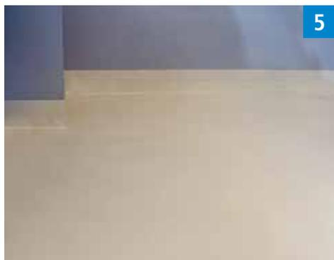
Appliquer ensuite la couche de finition des raccords et surfaces sous forme de surface « lisse » ou surface « Chips Design ».
