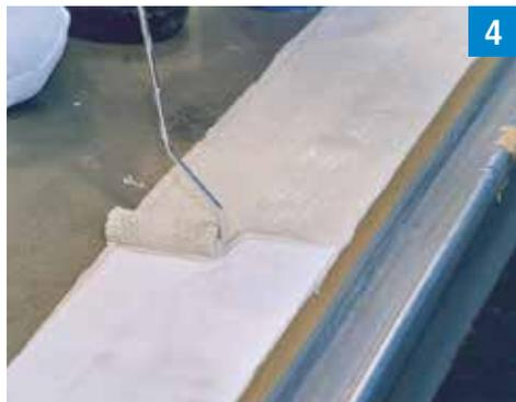
4 Puis, recouvrir de nouveau le voile de renfort d'une couche généreuse de résine d'étanchéité.
