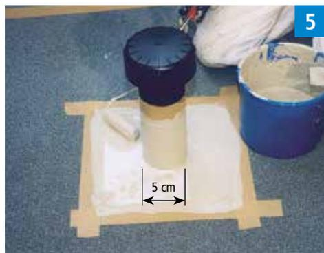
Appliquer la résine d'étanchéité sur la surface et placer la deuxième découpe pour la surface en veillant à éliminer toutes les bulles. Recouvrir généreusement sa face supérieure de résine.
