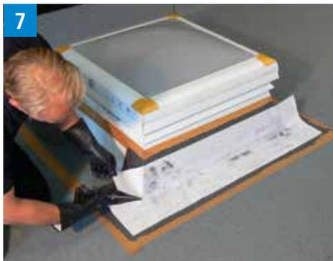
Rabattre les parties découpées de chaque côté du coin. Appliquer le voile de renfort sur la surface en veillant à éliminer toutes les bulles et recouvrir généreusement sa face supérieure de résine.
