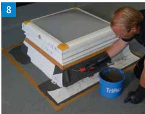
Appliquer généreusement la résine d'étanchéité sur la partie suivante de la surface.
