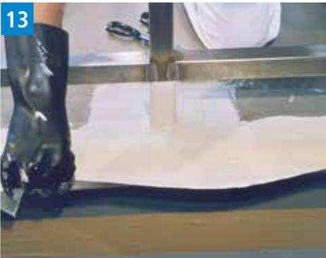
Appuyer avec le rouleau de manière à chasser toutes les bulles et recouvrir de nouveau d'une couche généreuse de résine d'étanchéité.
