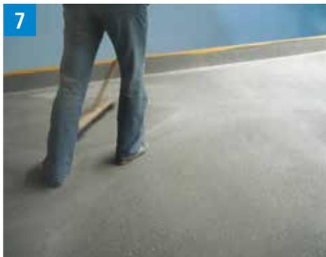
Puis, après une heure de temps de pause, appliquer Triflex Cryl Finition Satin à l'aide du rouleau de finition sur la surface ainsi préparée en effectuant des mouvements croisés.
