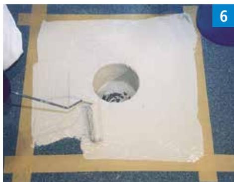
Appliquer généreusement la résine d'étanchéité sur la surface et dans la naissance.
