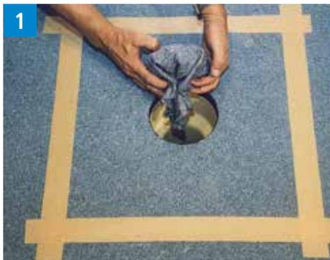
Nettoyer la naissance avec le produit Triflex Nettoyant et la rendre rugueuse manuellement avec du papier émeri.
