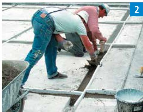
2 Comblent les réparations et les éclats au mortier après l'application de primaire.
