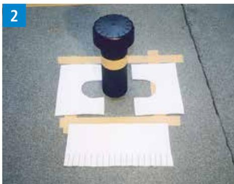
Appliquer généreusement la résine d'étanchéité sur la surface et au niveau du tube à l'aide d'un rouleau pour radiateurs ou d'un pinceau.
