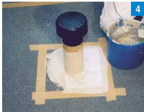
Appliquer la résine d'étanchéité sur la surface et placer la première découpe pour la surface en veillant à éliminer toutes les bulles. Recouvrir généreusement sa face supérieure de résine.
