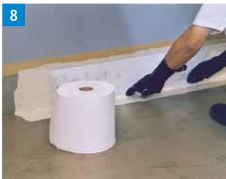
Pour les angles intérieurs, faire dépasser le voile de renfort de 5 cm du coin et inciser le pli de manière oblique jusqu'à l'angle au niveau du sol.
