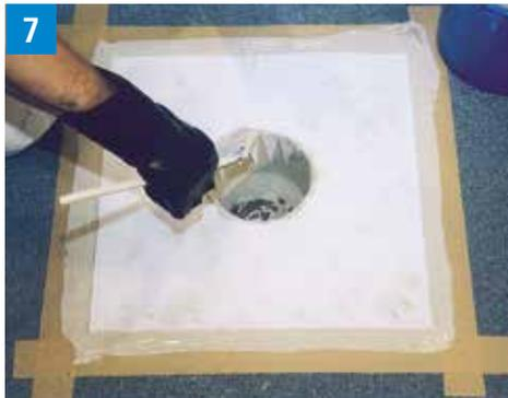
Puis, recouvrir généreusement la face supérieure du voile de renfort de résine.
