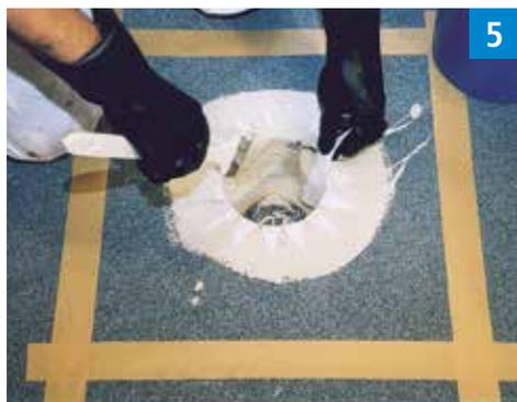
Appliquer généreusement la résine d'étanchéité dans et autour de la naissance et poser les découpes pour naissance en veillant à éliminer toutes les bulles.
