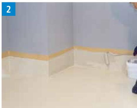
Injecter les micropaillettes Triflex Micro Chips dans la couche de finition encore fraîche de la surface verticale à l'aide du pistolet pulvérisateur à entonnoir.
