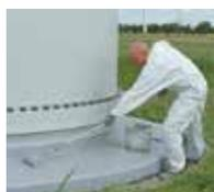
12. Pour finir, appliquer la couche de finition Triflex Towersafe Finition.
