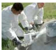
6. Appliquer du Triflex Towersafe sur les détails et poser le Triflex Voile de renfort en veillant à éliminer toutes les bulles ...
