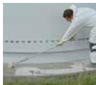
4. Appliquer une couche de Triflex Towersafe Primaire sur les fondations en béton.
