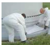
9. Puis, appliquer sur la surface de la base du Triflex Towersafe et poser du Triflex Voile de renfort ...
