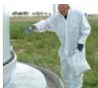
11. Il est possible d'injecter en option du sable de quartz dans la résine encore fraîche.
