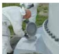
10. ... et recouvrir le tout d'une couche utile de Triflex Towersafe.
