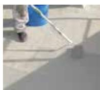
7. Si nécessaire, appliquer la couche de finition au bout d'env. 1 heure.
