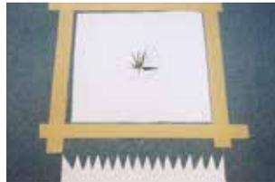
3. Fläche: 1 Vliesstück, das in der Mitte auf Gullydurchmesser sternförmig eingeschnitten wird.
