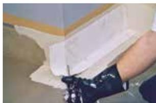
10. Bei Außenecken wird das Vlies 5 cm bis über die Ecke geführt und im Bodenbereich bis zur Ecke eingeschnitten. Anschließend wird der Einschnitt um die Ecke gelegt und der freie Bodenbereich wird mit einem zusätzlichen Vlieszuschnitt abgedeckt.
