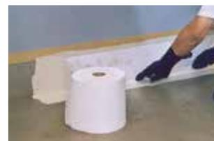
8. Anschließend das Triflex Spezialvlies im Zuschnitt oder von der Rolle blasenfrei in das frische Harz einlegen und dabei auf eine ausreichende Vliesdurchträngung achten.
