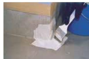
4. Anschließend die eingelegte Außenecke nochmals mit einer Lage Abdichtungsharz satt abdecken.
