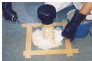
3. Abdichtungsharz satt (ca. 2,00 kg/m<sup>2</sup>) mit Heizkörperrolle oder Pinsel am Rohr und in der Fläche vorlegen. Anschließend den Vlieszuschnitt für das Rohr blasenfrei in das frische Harz einlegen und dabei auf eine ausreichende Vliesdurchtränkung achten.
