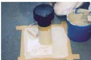
5. Abdichtungsharz in der Fläche vorlegen und den zweiten Zuschnitt für die Fläche blasenfrei einlegen und von oben satt abdecken.
