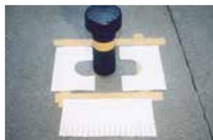
2. Fläche: 2 Vliesstücke die jeweils auf einer Seite U-förmig auf Rohrdurchmesser ausgeschnitten werden. Die beiden Vliesstücke müssen sich im Bereich des Rohres mind. 5 cm überlappen!
