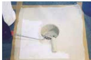
7. Anschließend das Vlies satt von oben mit Harz (ca. 1,00 kg/m<sup>2</sup>) abdecken.
