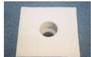
8. Das Putztuch aus dem Gully entfernen und das Klebeband im noch frischen Zustand abziehen. Fertig!
