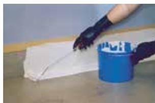
7. Abdichtungsharz satt (ca. 2,00 kg/m<sup>2</sup>) mit einer Heizkörperrolle im Wandanschlussbereich vorlegen.
