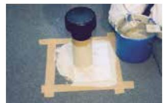
4. Abdichtungsharz in der Fläche vorlegen (ca. 2,00 kg/m<sup>2</sup>) und den ersten Zuschnitt für die Fläche blasenfrei einlegen und von oben (ca. 1,00 kg/m<sup>2</sup>) satt abdecken.
