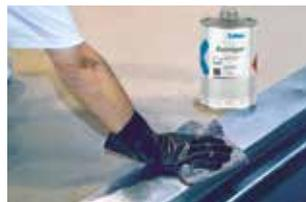
2. Metalle oder PVC werden vor dem Beschichten der Oberfläche mit Triflex Reiniger entfettet und anschließend angeraut (siehe weitere Fotos).
