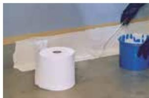
11. Danach das eingelegte Vlies mit einer Schicht Abdichtungsharz (ca. 1,00 kg/m<sup>2</sup>) satt abdecken.
