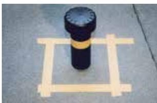
1. Lüfter in Abdichtungshöhe und Fläche in Abdichtungsbreite (min. 10 cm) abkleben. Triflex Spezialvlies-Zuschnitte erstellen. Rohr: Breite: 20 cm, Länge: Rohrumfang + 5 cm. Das Vlies wird über die ganze Länge 5 cm tief und 1 cm breit streifenförmig eingeschnitten.
