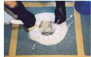
4. Abdichtungsharz in und um den Gully satt vorlegen (ca. 2,00 kg/m<sup>2</sup>) und den Zuschnitt für den Gully blasenfrei einlegen. Anschließend die sternförmigen Einschnitte auf die Fläche umlegen und das Vlies nochmals satt von oben (ca. 1,00 kg/m<sup>2</sup>) abdecken.
