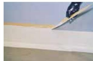
12. Das Klebeband im noch frischen Zustand entfernen. Fertig!
