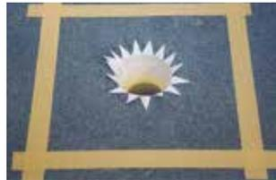
2. Triflex Spezialvlies-Zuschnitte erstellen. Gully: Breite: 15 cm, Länge: Gullyumfang + 5 cm. Das Vlies wird über die ganze Länge 5 cm tief und 1 cm breit sternförmig eingeschnitten.
