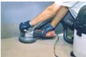
1. Saugende Untergründe (z.B. Beton, Asphalt) müssen mit einem Beton-Diamant-Schleifer geschliffen werden, um einen haft- und tragfähigen Untergrund zu erhalten.
