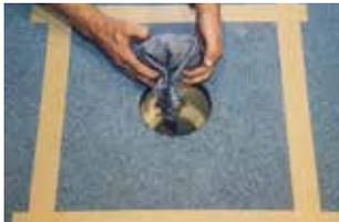
1. Fläche in Abdichtungsbreite abkleben und Gully mit einem Putztuch verstopfen. Den Gully mit Triflex Reiniger säubern und mit einem Handschleifpapier anrauen.
