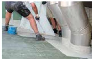
*Ein Gewirr aus Rohren überzieht das Dach des Sudhauses der Brauerei Diebels. Die Sanierung der komplizierten Fläche erfolgte mit dem Flüssigkunststoff Triflex ProDetail.*
