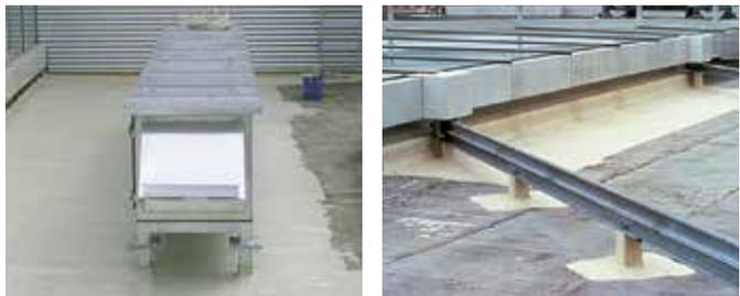
Die 210 Standfüße der Befahranlage auf dem Dach wurden mit Triflex ProDetail abgedichtet.
