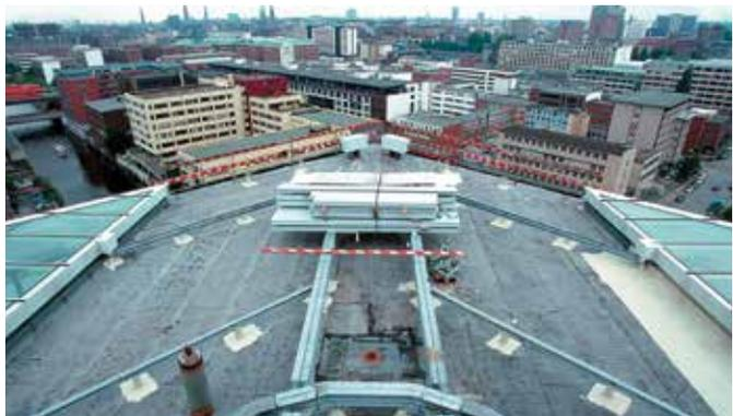
Die 20 bis 40 cm hohen Stahlbetonsockel der fahrbaren Glasdreiecke wurden problemlos in die Flächenabdichtung einbezogen.
