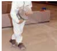
8. Für einen besseren Haftverbund wird eine zusätzliche Nuttschicht mit Triflex ProPark aufgetragen und mit Quarzsand abgestreut.
