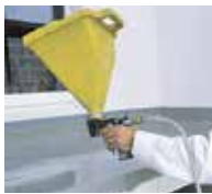
10. ... Triflex Micro Chips einblasen.
