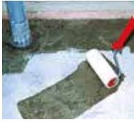
1. Wandanschluss und Fläche grundieren.
