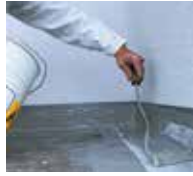
4. ... mit Triflex ProDetail satt nachlegen.
