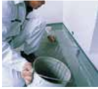
2. Anschlüsse mit Triflex ProDetail vorlegen.
