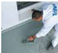
6. ... mit einer Kelle aufziehen und ...
