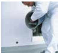
5. Die Flächenbeschichtung Triflex ProFloor ...
