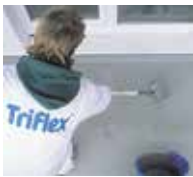
9. ... dann auf die Fläche aufbringen und ...
