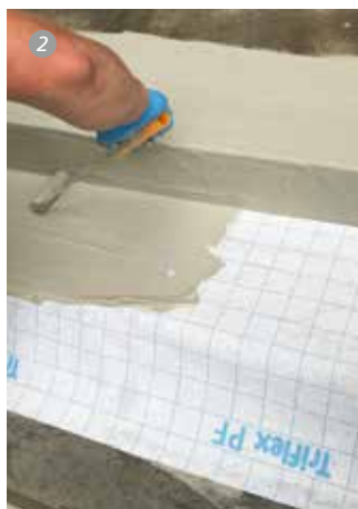
Uszczelnianie detali
