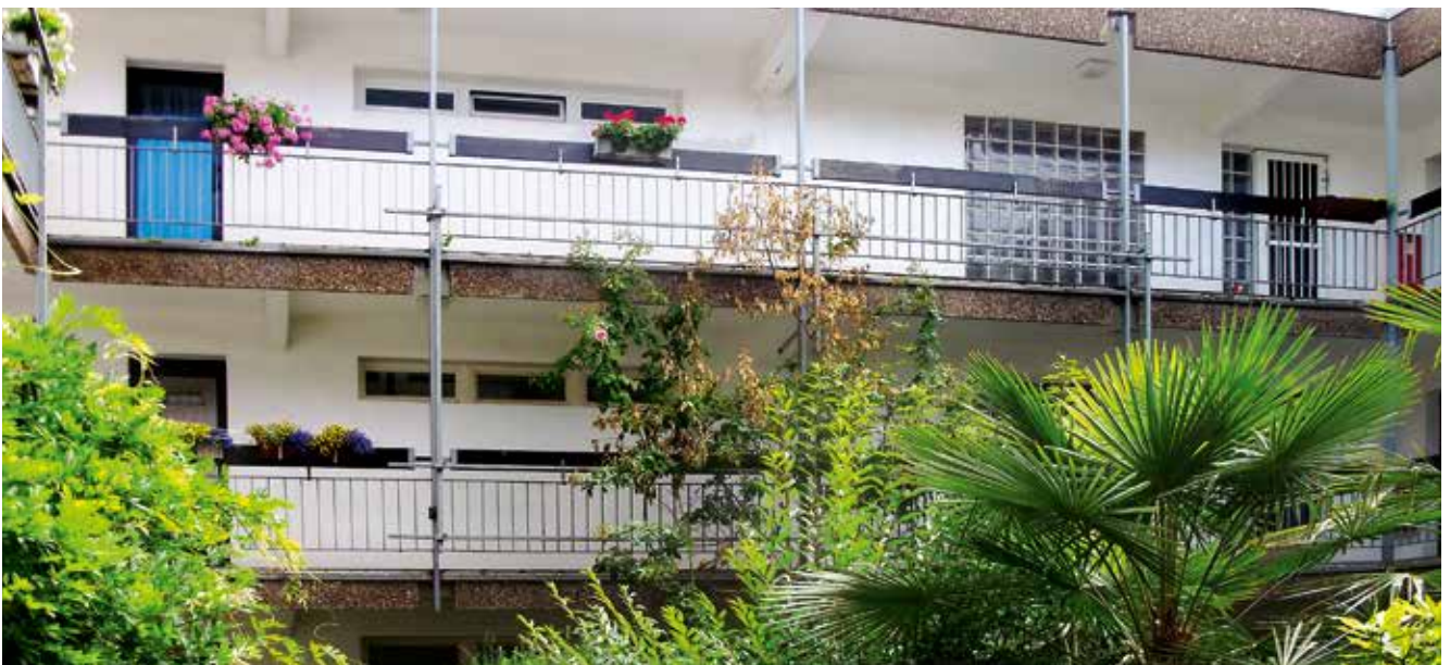
Das Mehrfamilienhaus Pillauer Weg in Kaarst nach der Sanierung mit Triflex
