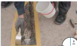
1. Die Ausbruchstelle muss sauber und trocken sein. Der saugende Untergrund wird grundiert.
