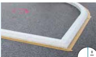
1. Der saubere und trockene Untergrund wird mit Kreppband abgeklebt.
