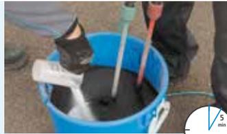
2. Harz, Füllstoff und Katalysator mischen.
