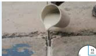
3. Fuge ggf. mit PE-Rundsnur versehen und mit Vergussmasse verfüllen.
