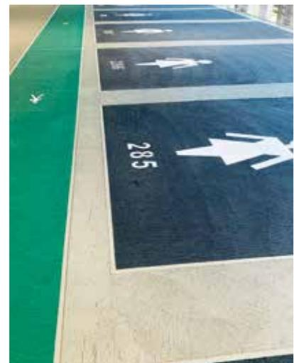
Für die Abdichtung kam das OS 10-System Triflex ProPark auf Basis von Polymethylmethacrylatharz (PMMA), Variante II zum Einsatz. Es bewährt sich in der Baupraxis seit vielen Jahren besonders in Parkbauten mit extremer Beanspruchung, da es mechanisch hoch belastbar ist und Sanierungsintervalle deutlich verlängert.
