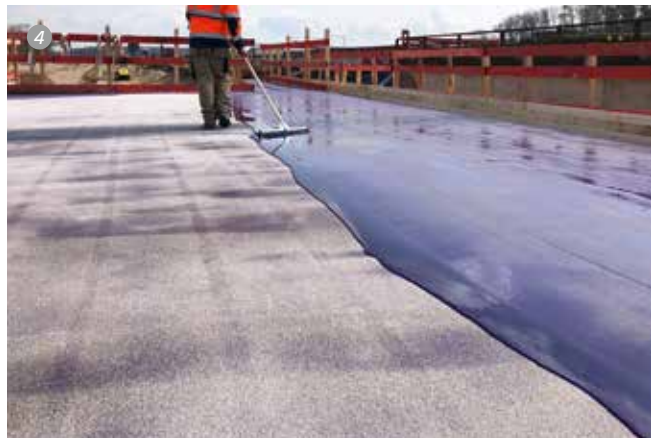
Zweite Schicht Triflex Bridge Deck Primer auftragen
