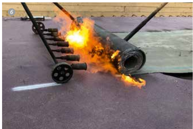
Aufschweißen der Polymerbitumen-Schweißbahn Vedapont BE
