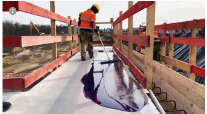
Auftragen von Triflex Bridge Deck Primer
