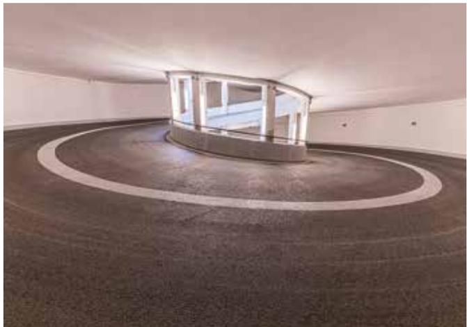
Während auf den Flächen Triflex ProPak in der Variante 1 zum Einsatz kam, fand an der Spindel die Variante 3 Anwendung. Die Farbgebung in Anthrazit soll Reifenspuren optisch verschwinden lassen. Das von oben einfallende Tageslicht leuchtet zusammen mit Stablichtern in den Laibungen die Fahrbahn aus.
