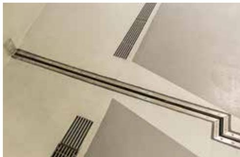
Die Bewegungsfugen wurden zum Teil mit Profilen der Firma Buchberger oder mit Triflex ProJoint ausgebildet.
