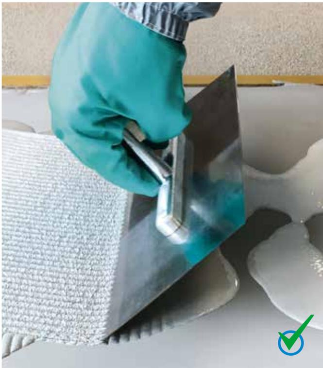
Das Stahlblech der Zahnkelle wird im 45° Winkel zur Oberfläche geführt, sodass ca. 4 kg/m<sup>2</sup> Material auf die Fläche aufgetragen wird. Das Auftragen des Materials erfolgt ohne große Druckausübung (keine Kratzspachtelung). Hieraus ergibt sich die für die Beschichtungssysteme Triflex ProFloor und Triflex DeckFloor vorgegebene Schichtdicke.
