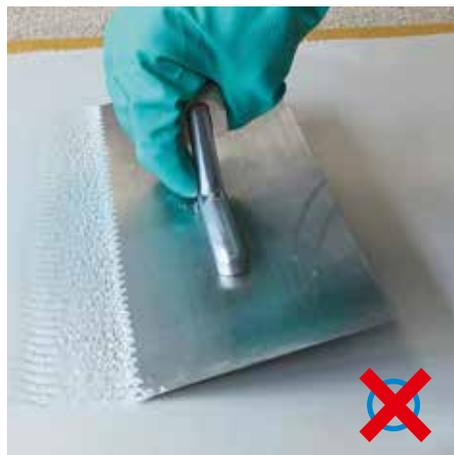
Eine flache Führung der Zahnkelle zur Oberfläche führt ebenfalls zur einem Nichterreichen der vorgegebenen Schichtdicke.
