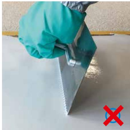
Ein Führen der Zahnkelle im nahezu senkrechten Bereich kann zu einem „Kratzen“ an der Oberfläche führen. Das Material wird demzufolge zu dünn aufgetragen.
