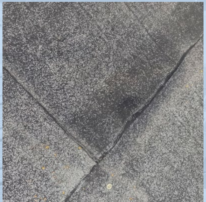
Kaum mehr vorhandener Oberflächenschutz bei der ersten Dachabdichtung. UV-Versprödung erkennbar.
