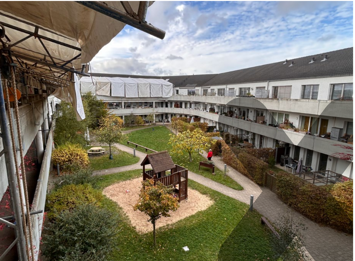
BALKONE, TERRASSEN, LAUBENGÄNGE
