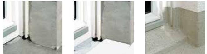
**Triflex BIS** ist ein speziell für Balkone und Dachterrassen entwickeltes Wärmedämmsystem, das zusammen mit dem Triflex BTS-P – Balkon Abdichtungssystem eingesetzt wird.
