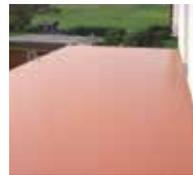
10. Im Anschluss wird das Abdichtungssystem Triflex BTS-P aufgebracht.
