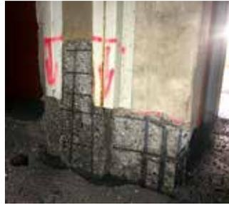
Aufgrund einer zu geringen Betonüberdeckung der Bewehrung waren Abplatzungen im Wandsockelbereich entstanden.
