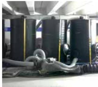
Vor Beginn der Beschichtungsarbeiten wurden Aktivkohlefilteranlagen installiert. Diese reinigen die Umluft, um die während der Verarbeitung entstehende Geruchsbildung für die Baubeteiligten sowie für die Anwohner auf ein Minimum zu reduzieren.
