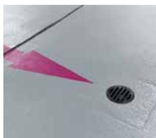
Details und Anschlüsse im Bereich der Rampen und oberen Decks wurden mit Triflex ProDetail und Triflex Spezialvlies abgedichtet.
