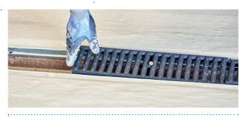
Im Fokus der Sanierungsmaßnahme stand auch die Entwässerung der Tiefgarage, die durch den Austausch der Ablaufrinnen erneuert wurde. Diese Übergänge dichteten die Handwerker ebenfalls mit Triflex ProDetail ab.
