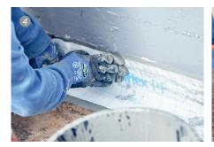
Mit dem vliesarmierten Triflex ProDetail dichteten die Verarbeiter insgesamt 200 lfm Anschlüsse an aufgehenden Wänden ab.
