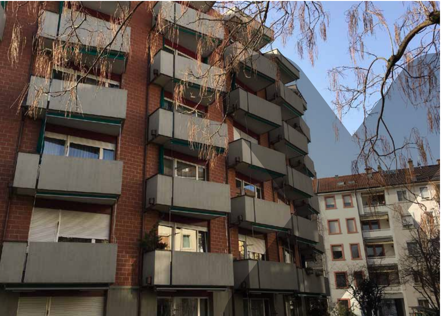
BALKONE | TERRASSEN | LAUBENGÄNGE
