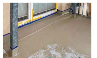
„DER ESTRICH LÄSST SICH DURCH SEINE EINFACHE HANDHABUNG SEHR LEICHT VERARBEITEN UND MAN ERHÄLT NACH DEM ABREIBEN EINE SCHÖNE GLATTE OBERFLÄCHE. DURCH DIE KURZEN SPERRZEITEN KANN AN NUR EINEM TAG EIN BALKON VOM ESTRICH BIS ZUR ABDICHTUNG FERTIGGESTELLT WERDEN“
