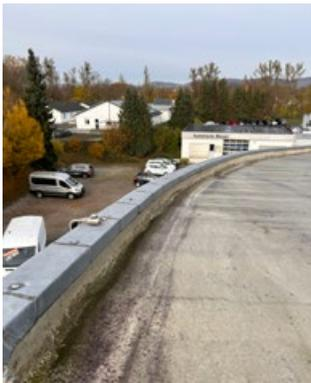
Auch die innenliegende Wasserführung sowie die Attika wurden mit Triflex ProDetail abgedichtet.
