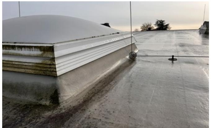
Ein besonderes Augenmerk lag dabei auf der Anschlussabdichtung. So wurden die Übergänge beispielsweise zu den zahlreichen Lichtkuppeln ebenso wie die Fläche mit Triflex ProDetail bearbeitet und somit naht- sowie fugenlos eingebunden.
