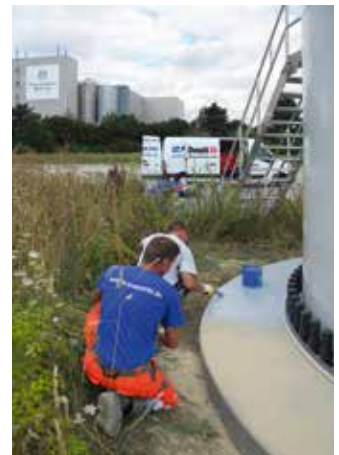
Auftragen von Triflex Towersafe Finish mit Quarzsandeinstreuung
