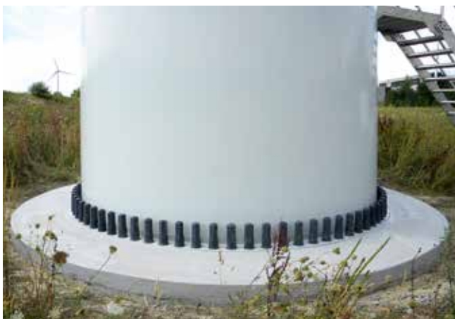
Am windreichsten Standort im Raum Paderborn ist die Anlage hohen Windlasten ausgesetzt. Diese haben enorme Auswirkungen auf das Fundament
