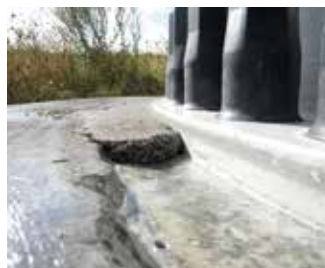
Einbau des Triflex Cryl RS 240 Mörtels
