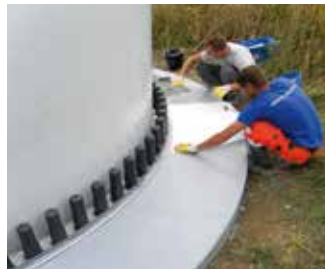
Das Triflex Spezialvlies wird eingearbeitet
