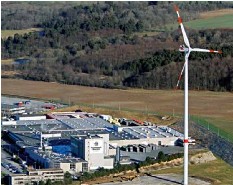
Die Paderborner Brauerei nach der Sanierung mit Triflex Towersafe
