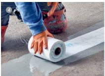
Die Armierung aus Vlies verstärkt das Triflex Beschichtungssystem und ist somit vollflächig fugenüberspannend und homogen dicht.
