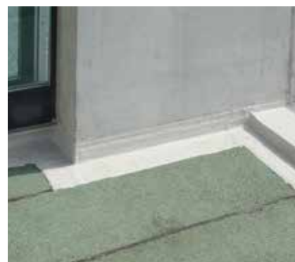
Tetto piano – Collegamento alla parete
