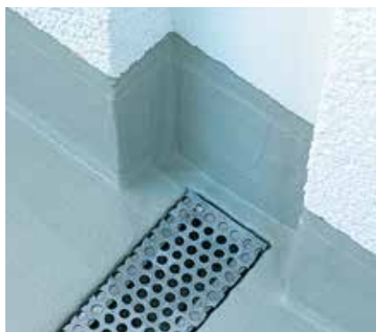
Balconi – Pozzetto e canale sporgente
