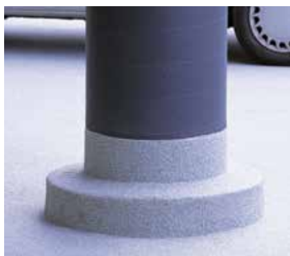
Piani di parcheggio – Collegamento al montante
