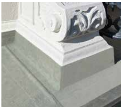
Balconi – Collegamento alla parete
