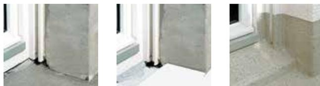
**Triflex BIS** è un sistema termoisolante sviluppato appositamente per balconi e terrazze su tetto che può essere impiegato insieme al sistema d'impermeabilizzazione per balconi Triflex BTS-P.
