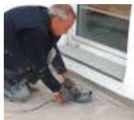
1. Pretrattare il sottofondo, ad es. con levigatura o fresatura.
