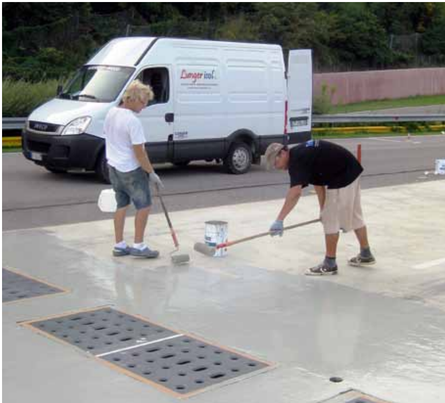
Anche le bande di misurazione vengono integrate nella superficie rivestita senza saldature.
