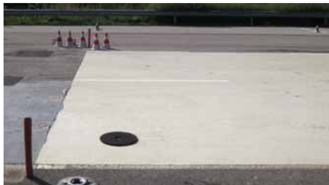
L'area di ampliamento viene innanzitutto pulita e levigata.
