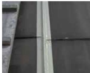
Die mit Triflex ProDetail abgedichteten T-Profile benötigen auf Glas und Metall keine Grundierung.
