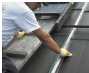
Verschmutzungen, Roststellen und lose Partikel wurden entfernt und die Glasflächen vor dem Aufbringen der Abdichtung mit Triflex Reiniger behandelt.
