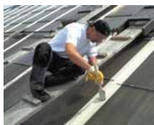
Meter für Meter wurde die vliesarmierte Abdichtung mit dem Pinsel aufgetragen.
