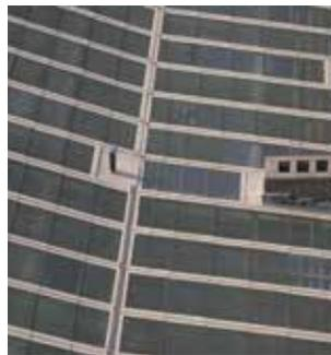
Die mit Drahtglas gedeckten Sattel- und Walmdächer des Pergamonmuseums wurden im Zeitraum 2001 bis 2004 saniert. Die homogene Einbindung von allen möglichen Dachgeometrien gelingt mit der Flüssigabdichtung nahtlos.
