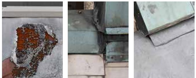
*Das Sheddach mit seinen wellenförmigen Dachflächen stellt erhöhte Anforderungen an Abdichtungssysteme. Die Bauwerksschäden waren nicht zu übersehen. Besonders die Haftung auf PU-Ortschaum war mangelhaft. Gerade bei schwierigen Details und Ecklösungen bietet Triflex ProDetail ideale Lösungen zur Dachabdichtung.*
