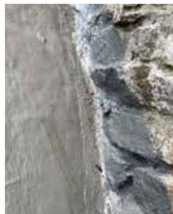
Die Verarbeiter applizierten das Spezialharz im Spritztechnik-Verfahren. Diese Methode hat den Vorteil, dass sie sich vor allem für schwer zugängliche Bereiche und komplizierte Geometrien eignet. Das flüssige Material mit Vliesarmierung legt sich an alle Gegebenheiten wie eine zweite Haut an und bildet nach kurzer Aushärtungszeit einen langfristigen Schutz vor Feuchteintrag.
