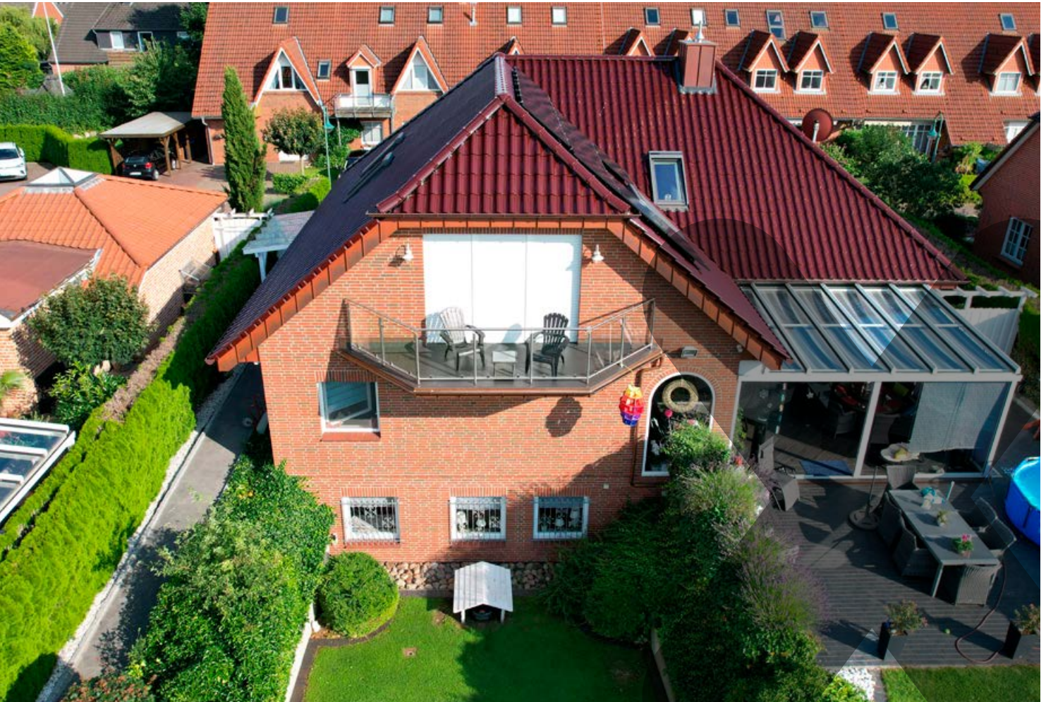
BALKONE, TERRASSEN, LAUBENGÄNGE
