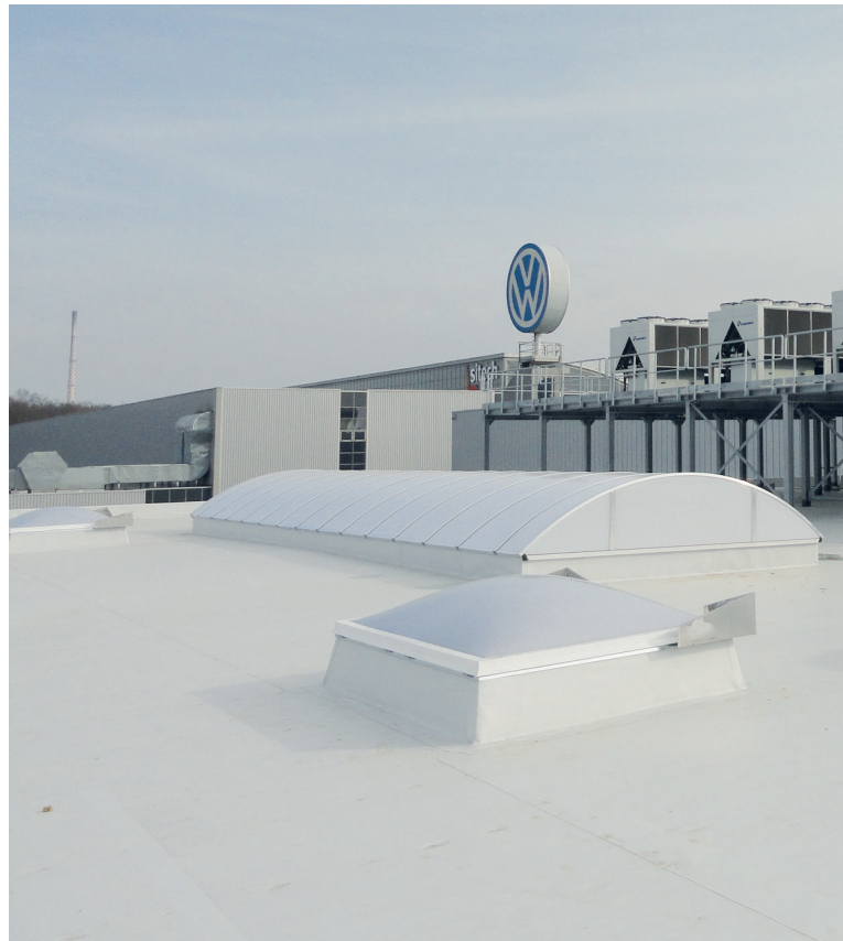
Dachfläche einer weiß beschichteten Fertigungshalle von VW Motor Polska.
