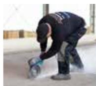
2. Poser des découpes destinées à isoler 10 cm à gauche et à droite de la fissure.
