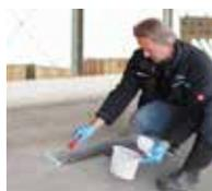
3. Recouvrir la surface de primaire, des découpes destinées à isoler et sceller les fissures.
