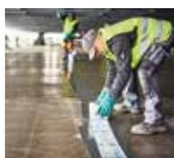
4. Appliquer la résine d'étanchéité Triflex ProPark, poser Triflex Voile de renfort...
